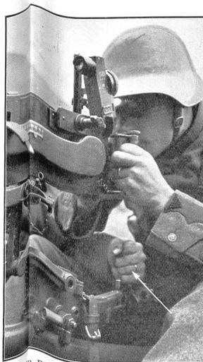
Ist beim Flächenfeuer über 8% Tiefenfeuer anzuwenden, so hat der Schießgehilfe das Höhenrichtrad zu bedienen, wobei vorteilhaft wiewo möglich der Schraubenzieher in das Rad einzusetzen ist. (A Er 437.)
