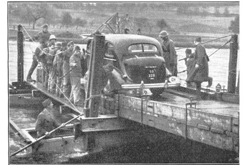
Die Drahtseilgeländer sind noch nicht gestreckt, als der erste Wagen zum Uebersetzen auf die Fähre dirigiert wird. Knapp 45 Minuten dauerte der Einbau der Fähre. (A Er 0305.)
