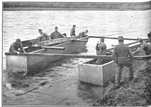
Auf die Länge der Stirnbalken wird der linke Ponton abgestoßen, indes in der Mitte bereits mit dem Aufbau der Ladebrücke begonnen wird. (A Er 0307.)
