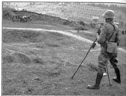
Sofort nach dem Stellungsbezug richtet der Schießoffizier die Geschütze mit Hilfe des Batterie-Instrumentes auf einen Zielstellungspunkt ein. (VI Br 4171.)
