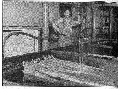
Vorgängig dem eigentlichen Gerbprozeß müssen die Häute in der Wasserwerkstatt bis zur Quellung aufgeweicht werden.
