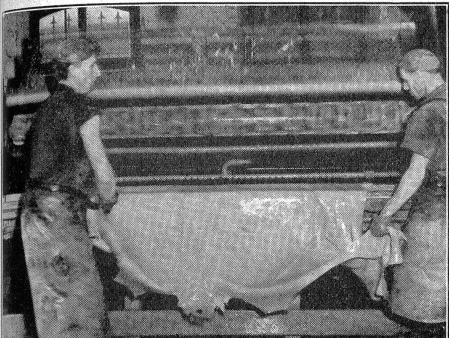
Anschließend daran werden sie in Spezialmaschinen gründlich gereinigt, die Haarnarbe wird entfernt.
