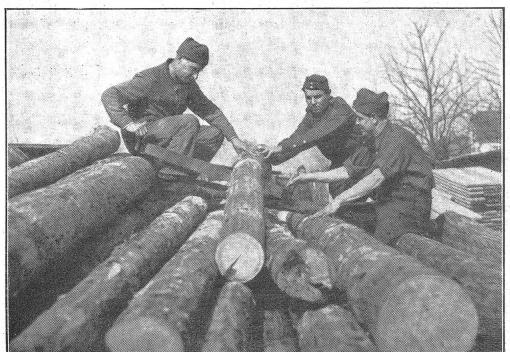
Links: Rundholz muß in ganz verschiedenen Durchmessern vorrätig sein; auch hier ist der Bedarf sehr groß: ein gegen 7,5-cm-Geschosse volltreffer-sicherer Unterstand für 16 Mann verlangt rund 23 Kubikmeter Rundholz. (A N 079.)
