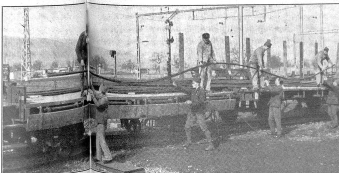
Das für Arbeiten in armer Beton nötige Rundseisen wird im Materialdepot auf die verlangten Größen zugeschnitten. Dieser Beton-Mg-Stand bedarf rund 1800 kg Rundseile. (A N 078.)
