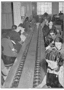
Die Nachkontrolle und das Auspolieren der Geschoßkörper am laufenden Band.
