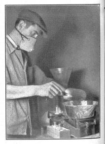
In der Leuchtsatz-Mischerei schützt sich die Belegschaft durch Staubschutzmasken gegen Schädigungen der Luftwege.
