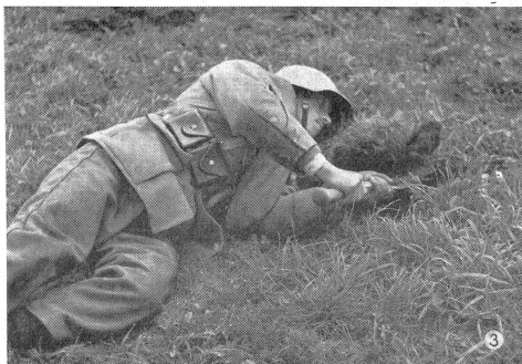
Mit einfachem Hebeldruck läßt sich oft der ringsum abgestochene Rasen- ziegel abheben. Souvent, une simple pression sur le manche de la bêche permet d'arracher d'un seul coup la motte de terre préalablement découpée. Non di rado, appoggiando leggermente sul manico dell'attrezzo, si può levare tutta la zolla erbosa tagliata intorno.
