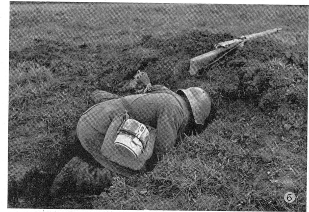
Beginn des Aushubes des Schützenloches aus der Schützenmulde heraus. Début de la transformation de l'excavation en «trou de tireur». Inizio dei lavori di scavo per una buca per tiratore, da una cunetta per tiratore.
