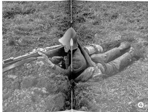
Durch öfteren Anschlag ist die Zweckmäßigkeit der stets höher werdenden Brustwehr als Ge- wehrauflage zu kontrollieren. Pour pouvoir tirer commodément, le parapet est utilisé comme support de fusil. Il convient de le vérifier souvent pendant le travail de creusement. Man mano che il parapetto si alza, si controllerà se esso può servire da sostegno efficace per il fucile, mettendo più volte l'arma alla spalla.
