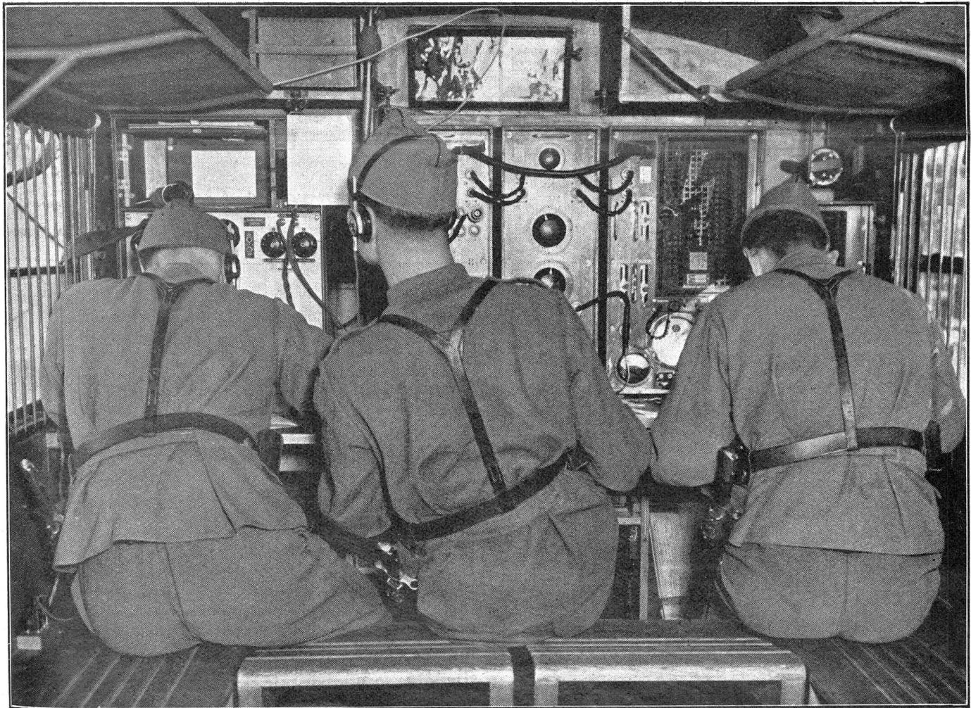
Allerlei Funkmaterial. Sende- und Empfangsapparatur der schweren Motorfunkstationen (SM. Fk. Sta.), fest eingebaut in Motorlastwagen. Die Reichweite dieser Langwellen-Stationen beträgt 500 km.
