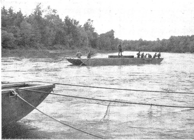
Verankern eines Ponton-Vierteilers aus Leichtmetall und Einfahren in die Brückenlinie.
