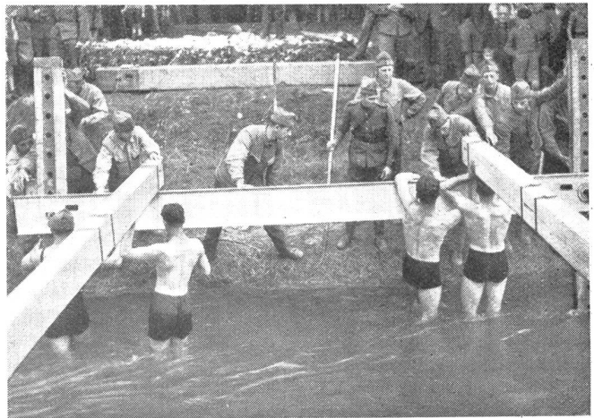
Einbau eines Bockes von Hand am jenseitigen Brückende. Dabei kommen einige Leute des Bautrupps zu einem im Juli nicht unwillkommenen Bad.
