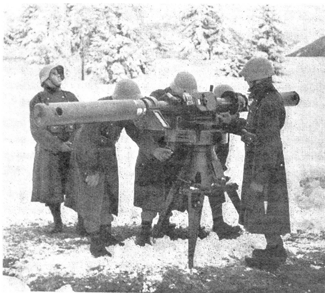
Der 3-m-Basis-Telemeter der FLAB-Batterie dient zum genauesten Ermitteln der Entfernung und der Höhe der zu beschießenden Flugzeuge unabhängig vom Batterie-Kommandogerät.
