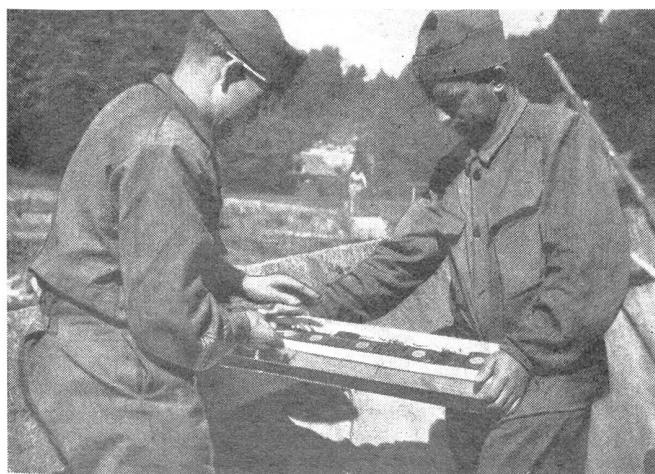
Anfertigen einer gestreckten Sprengladung. Die Sprengpatronen werden in einen vorbereiteten Holzrahmen eingesetzt.
