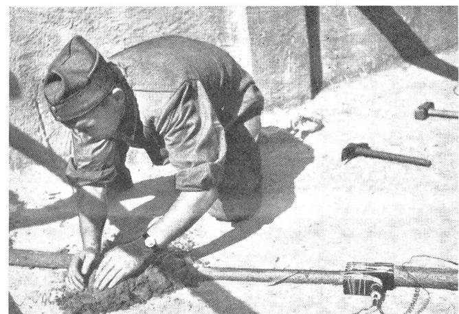
Die geballten Sprengladungen werden nach ihrem Anschluß an die Zündleitung verdämmt, durch Aufbringen von erdigem Material. Die Sprengwirkung wird so stark vergrößert.
