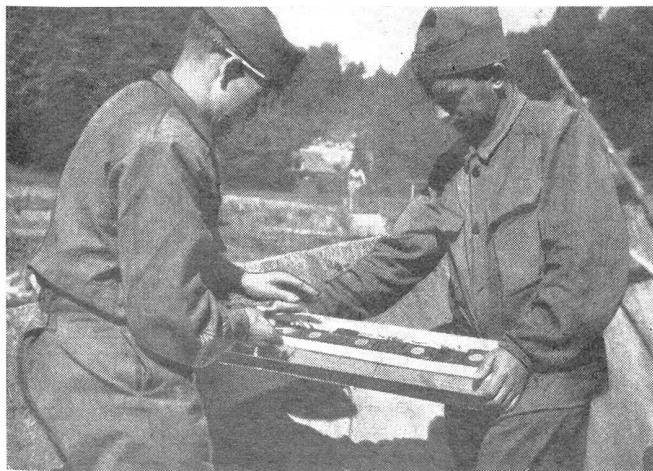
Anfertigen einer gestreckten Sprengladung. Die Sprengpatronen werden in einen vorbereiteten Holzrahmen eingesetzt.
