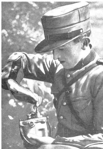
Das Kommando « Feuer » wurde gegeben. Die Sprengladung wird mittels des elektrischen Zündapparates zur Explosion gebracht.
