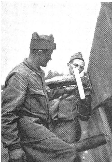
Die gestreckten Sprengladungen werden mittels Rundhölzern an die zu sprengende Seitenwand angepreßt.
