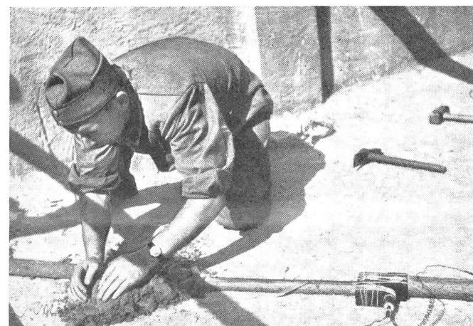
Die geballten Sprengladungen werden nach ihrem Anschluß an die Zündleitung verdämmt, durch Aufbringen von erdigem Material. Die Sprengwirkung wird so stark vergrößert.
