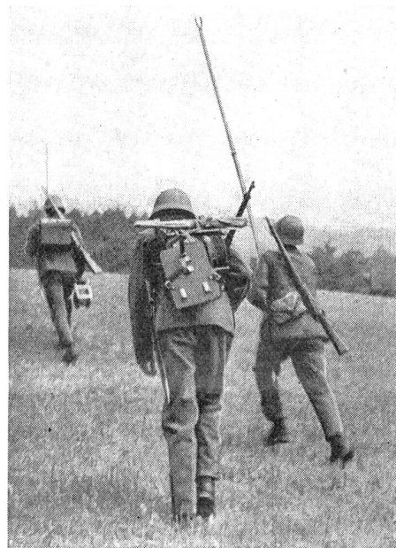
Wettübungen der Telephonpatrouillen. Die den Patrouillen gestellte Aufgabe verlangte den Bau einer eindrahtigen Gefechtslinie über eine Strecke von etwas mehr als 2 km. Im Laufschrift wurde von den meisten Trupps die Aufgabe gelöst.
