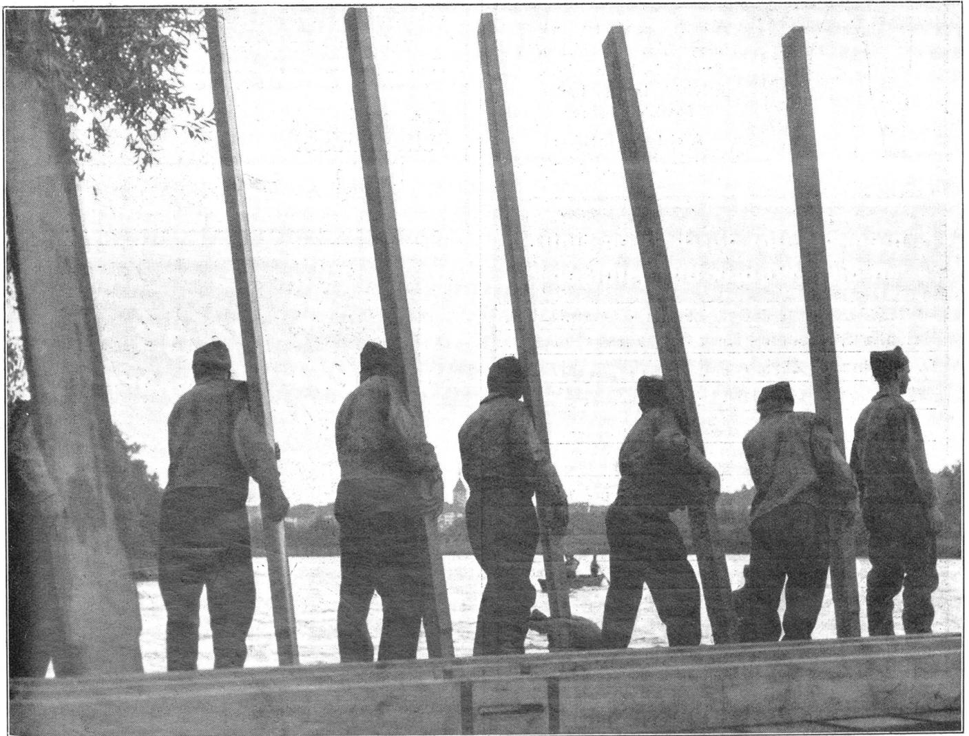
Bau einer Schiffbrücke durch unsere Pontoniere. Der Ladentrupp steht bereit, die starken Brückenladen auf die ausgelegten Streckbalken zu verlegen.
