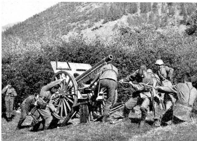
Durch die Einführung besonderer Böcke, auf welche die Geschützräder gestellt werden, war es in Verbindung mit einer andern Geschößform möglich, die praktische Höchstschißweite des 7,5-cm-Feldgeschützes 1903 von nur 5—6 km auf rund 11 km zu steigern. Unser Bild zeigt das Aufziehen eines 7,5-cm-Geschützes auf diese Böcke.
