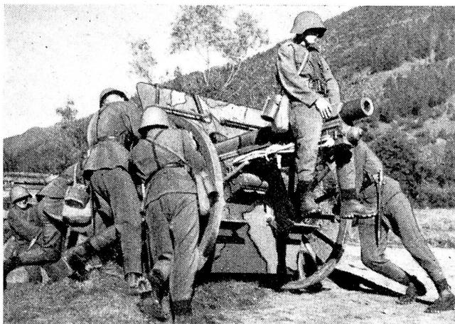
Da der Motorzug — mehr als der Pferdezug — an die Straßen gebunden ist, wird bei der motorisierten Artillerie der Stellungsbezug abseits von Straßen durch die Kanoniere von Hand besorgt werden müssen. Um bei Geländehindernissen die Lafette zu entlasten, wird das Rohr durch einen Mann «beschwert».
