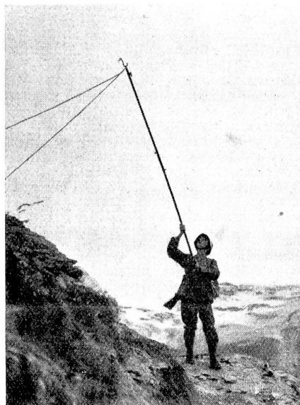
Die Verbindung zwischen den Kommandoposten der Kampfkompanien mit dem Bataillon wird in erster Linie durch die Telephonpatrouillen hergestellt, die selbst im schwierigsten Gebirgsgelände ihre Leitungen zu legen und zu unterhalten haben. Erst wenn das Telefon als Verbindungsmittel versagt, werden Meldeläufer eingesetzt.
