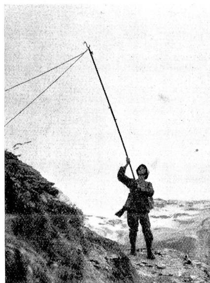
Die Verbindung zwischen den Kommandoposten der Kampfkompanien mit dem Bataillon wird in erster Linie durch die Telephonpatrouillen hergestellt, die selbst im schwierigsten Gebirgsgelände ihre Leitungen zu legen und zu unterhalten haben. Erst wenn das Telephon als Verbindungsmitte versagt, werden Meldeläufer eingesetzt.
