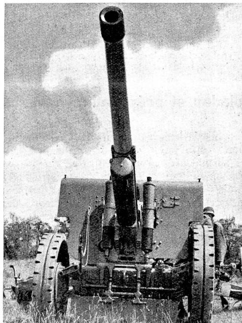
Schußbereite 10,5-cm-Bofors-Kanone in mittlerer Elevation. Mächtig ragt das 4,4 m lange Geschützrohr in die Luft empor. Das Geschütz verfügt über ein Höhenrichtfeld von 800 Promille und über ein Seitenrichtfeld von 1065 Promille. Seine maximale Schußweite beträgt auf eine Höhe von 1000 m ü. M. 18,500 Meter. Vorn am Schutzschild die beiden Gewichtsausgleichsbremsen des Rohres, darunter in der Mitte das umgelegte vordere Marschlager des Rohres.
