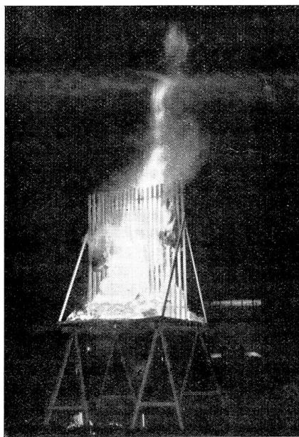
Wie eine Brandbombe in einem unentrümpelten Dachraum innerhalb zweier Minuten zu wirken vermag, geht aus diesem Bilde deutlich hervor. Die herumliegenden Lumpen und Kartonschachteln, die am Holzverschlag aufgehängten ausrangierten Kleider, bieten der flammen-sprühenden Wirkung der Brandbombe guten Nährboden. Es wird schwer sein, einem solchen Brandherd nur mit Hilfe der noch aufzustellenden Hausfeuerwehren beizukommen.
