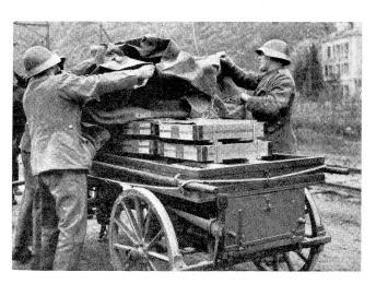
Die Ladefähigkeit eines Munitions-Brückenwagens beträgt 10 Munitionskisten zu je 5 Schuß, was einem Gewicht von rund 500 kg entspricht. Für den Marsch werden die Fuhrwerke mit Blachen gedeckt.
