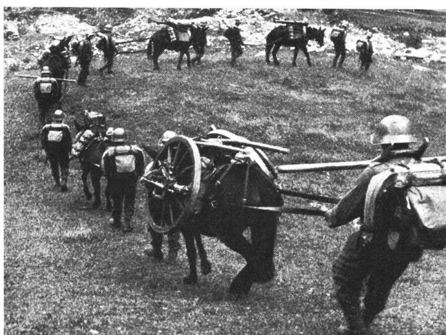
Saumkolonne eines Bofors-Gebirgsgeschützes im Abstieg. Die im Bild sichtbaren fünf Tiere bilden die erste Fahreinheit für den Marsch in fahrbarem Gelände: voraus geht das Rohrtier, gefolgt vom Schlittentier, Wiegentier, Bodenstücktier und ersten Radtier. Der Kanonier rechts trägt einen Hebebaum zum Ab- und Aufladen der einzelnen Geschützteile.
