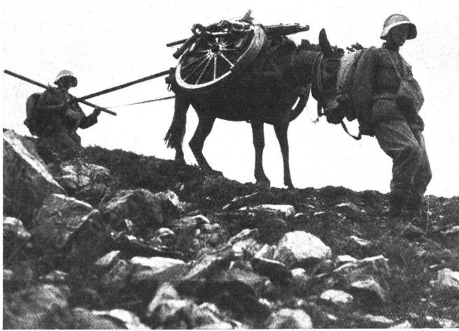
Für den Transport der Gebirgsgeschütze in fahrbarem Gelände kann dieses in zwei Fahrzeuge zusammengelegt werden. Dies bedingt die Mitnahme von vier Rädern für jedes Geschütz, die auf zwei Saumtiere verteilt sind.
