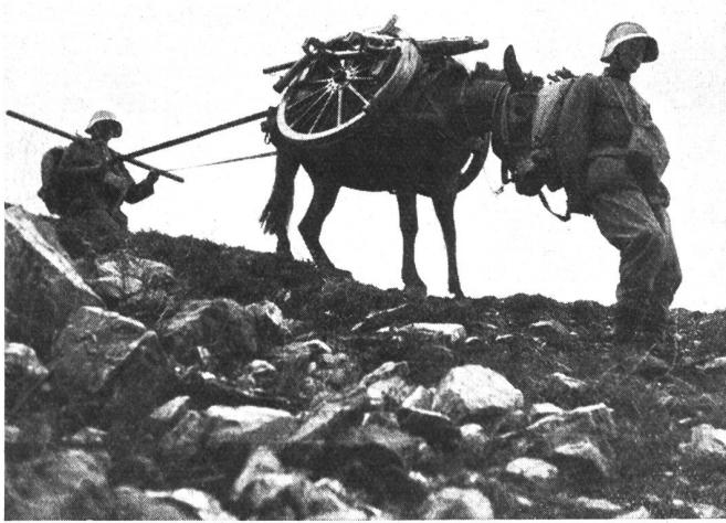
Für den Transport der Gebirgsgeschütze in fahrbarem Gelände kann dieses in zwei Fahrzeugeien zusammengesetzt werden. Dies bedingt die Mitnahme von vier Rädern für jedes Geschütz, die auf zwei Saumtiere verteilt sind.
