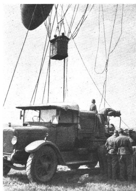
Die Artilleriebeobachtung auf größere Distanz erfolgt hauptsächlich von Fesselballons aus, die bis auf eine Höhe von 2000 m über Standort steigen gelassen werden können. Die Beobachter sind telefonisch mit der Erde verbunden.
