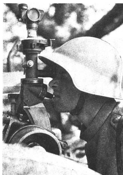
Vom Kommandoposten, der telefonisch mit der Batterie verbunden ist, werden mittels eines Scherenfernrohrs die Wirkung des Feuers der eigenen Batterie beobachtet und notwendige Korrekturen durch das Telefon zur Batterie zurückgegeben.
