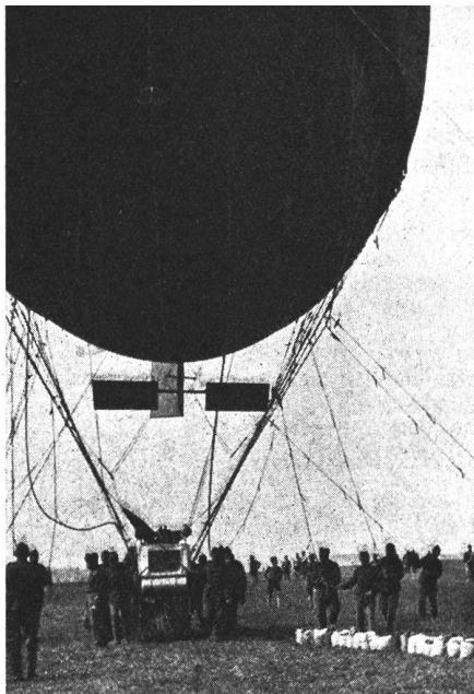
**M 3 startet.** Gleich wie ein Ballonkorb wird auch die Motorgondel mit starken Tauen am Ballon befestigt. Für das Manövrieren des Ballons am Boden ist der Gondeltrupp noch an der Motorgondel, während die Ballontruppe noch nach beiden Seiten hin die Halteseile des Ballons bedienen.
