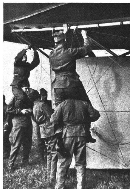
**M 3 startet.** Am Heck des Ballons wird die Kielflosse mittels Riemen befestigt, die ähnlich wie der Kiel eines Schiffes die Führung des Ballons, bzw. seine Haltung in der Luft ermöglicht.
