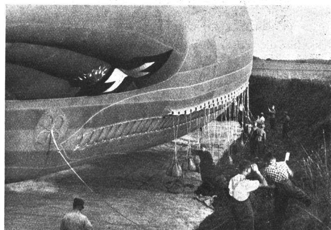
**M 3 startet.** Ueber Nacht wird die gefüllte Ballonhülle jeweils gänzlich eingezogen und fest am Boden verankert, dies geschieht zweckmäßig zum Schutz gegen Wind in Bodensenkungen oder Mulden, wie Steingruben usw. Ausgebreite Blachen schützen die Ballonhülle gegen Beschädigungen durch Steine und dergleichen.
