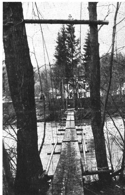
Arbeiten unserer Genietruppen. — Fertiger Hängesteg. Travaux de nos troupes du génie. — Passerelle suspendue. I lavori delle nostre truppe del genio. — Passaggio sospeso ultimato. Phot. Hohl, Arch.
