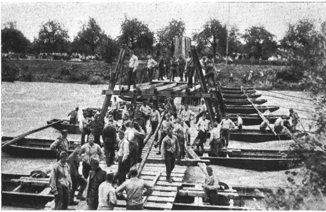
Arbeiten unserer Genietruppen. — Etagenbrücke im Bau. Travaux de nos troupes du génie. — Pont à étages en construction. I lavori delle nostre truppe del genio. — Alla costruzione di un ponte a due piani. Phot. Hohl, Arch.
