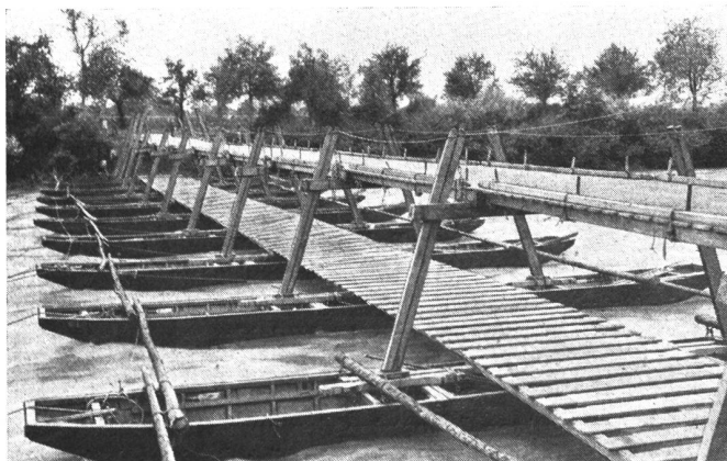
Arbeiten unserer Genietruppen. — Fertiggestellte Etagenbrücke. Travaux de nos troupes du génie. — Pont à étages terminé. I lavori delle nostre truppe del genio. — Il doppio ponte collaudato. Phot. Hohl, Arch.
