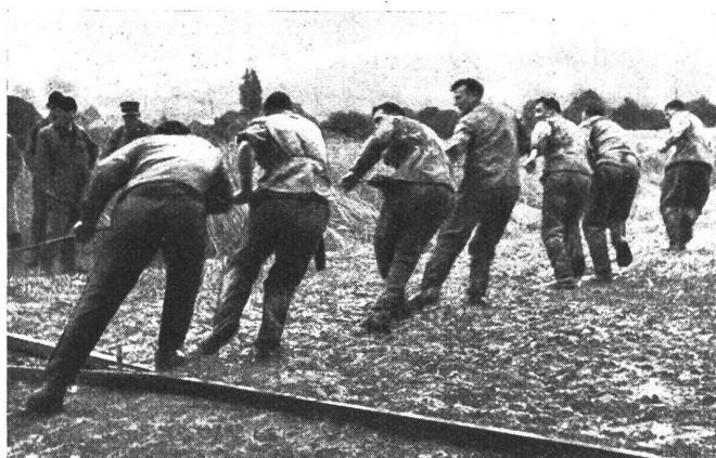
Beim Einziehen des Drahtkabels der Bootsfähre. Phot. K. Egli, Zürich. Retrait du câble du bateau-bac.
