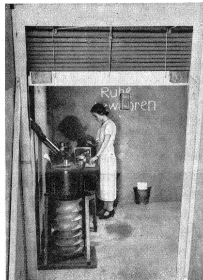
Passiver Luftschutz. Luftschutz-Raum. Blick in den Luftschutzraum von außen her. Mittels einer Jalousietüre aus imprägniertem Segeltuch-Gummistoff ist hier eine sog. Gasschleuse hergestellt, wie sie bei keinem Luftschutzraum fehlen darf. Hier spritzen sich alle Personen, die den Schutzraum benützen wollen, vor dessen Betreten mit Chlorkalklösung ab, d. h. sie desinfizieren sich gegen event. schon anhaftende Gase. Die Gasschleuse liegt zwischen dem Luftschutz-Vorraum und dem eigentlichen Luftschutzraum. Vorn im Bild links ist ein mechanischer Luftzuführapparat mit Reinigungsfilter sichtbar, mit welchem bei starker Beladung des Schutzraumes der Aufenthalt darin beliebig lang ermöglicht wird.
