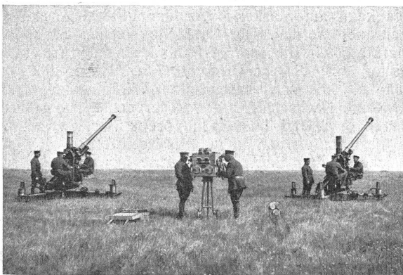
Aufstellung einer zweigeschützigen Luftabwehrbatterie 75 mm (Schneider) mit Kommandogerät. Matériel contre avions de 75 mm «Schneider». Canon léger de campagne. Section de 2 pièces avec correcteur «Schneider».
