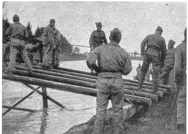
Beim Erstellen des Brückenkopfes Construction de la tête du pont
