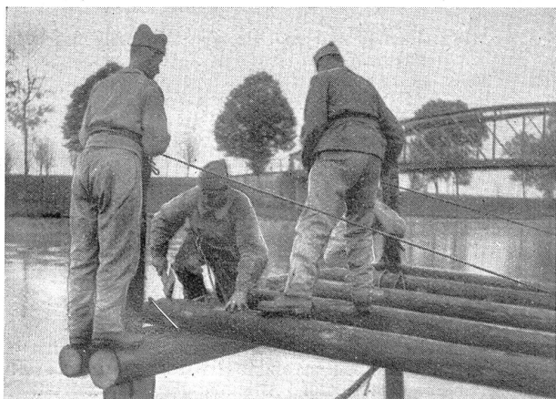
Der Bock ist ausgelegt. Der Bautrupps setzt die Tragbalken ein
