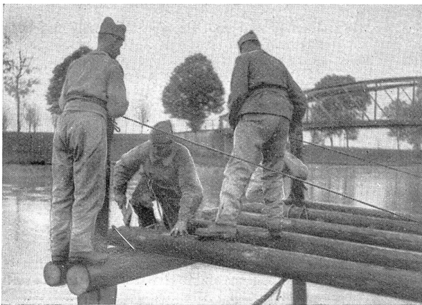
Der Bock ist ausgelegt. Der Bautrupps setzt die Tragbalken ein Le chevalet est placé. Les soldats constructeurs posent les poutres Phot. K. Egli, Zürich
