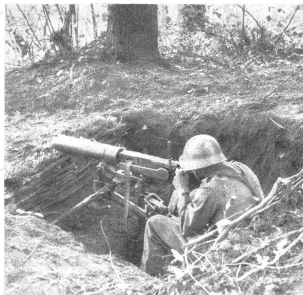
Der Gebrauch des kleinen Schanzwerkzeuges bei der Infanterie Bild 10: Maschinengewehrnest für sitzenden Schützen. Brustwehr und Rückwand des Sitzes sind mit Strauchwerk verkleidet. In den Seitenwänden r. u. l. könnten Munitionsdeckungen geschaffen werden.
