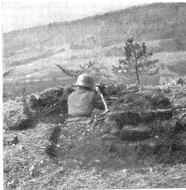
Der Gebrauch des kleinen Schanzwerkzeuges bei der Infanterie Bild 8: Lmg.-Nest für sitzenden Schützen. Brustwehr mit Strauchwerk verkleidet. Im Vordergrund ein Kriechgraben zum nächsten Schützenloch führend.
