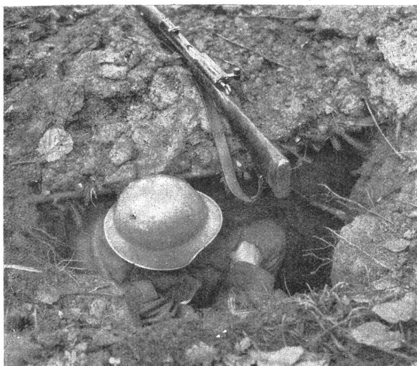
Der Gebrauch des kleinen Schanzwerkzeuges bei der Infanterie Bild 7: Schützennest für stehenden Schützen, bietet ihm während Feuerpausen Sitzgelegenheit. Zur Deckung gegen Splitter könnte das Schützenloch mit Bohlen überdeckt werden.
