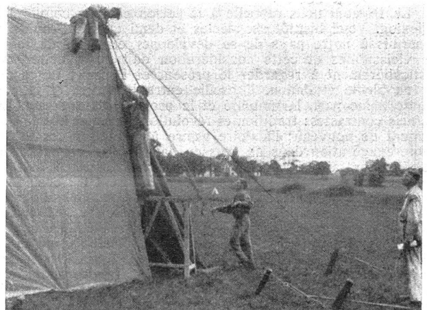
Zeltbau; Zuknöpfen des fertiggestellten Zelttes. — Montage d'une tente. Fermeture de la tente complètement terminée.
