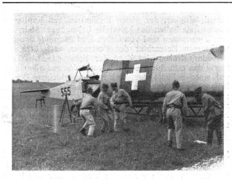
Vollständig demontiertes Flugzeug, bereit für den Straßentransport. Avion complètement démonté, prêt pour le transport par route. Phot. Hptm. Högger, Dübendorf
