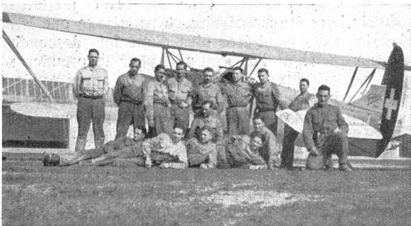
Service technique — Technischer Dienst
