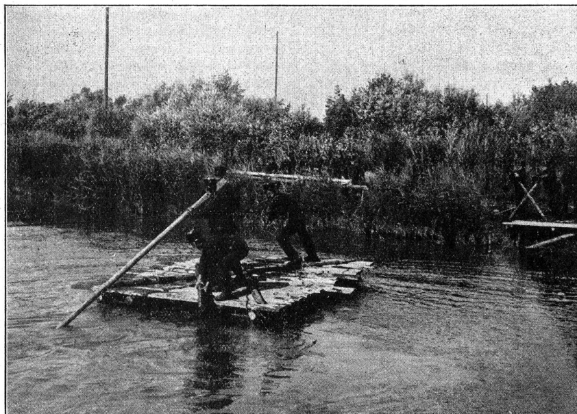
Aktivdienst 1917. Fassfloss auf einem Kanal. Er- baut durch die Sappeure.
