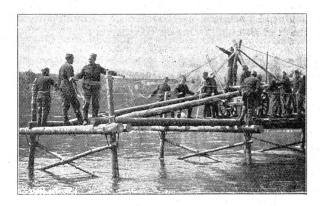
Einbauwagen für Kolonnenbrücke aus Notmaterial in Tätigkeit.
