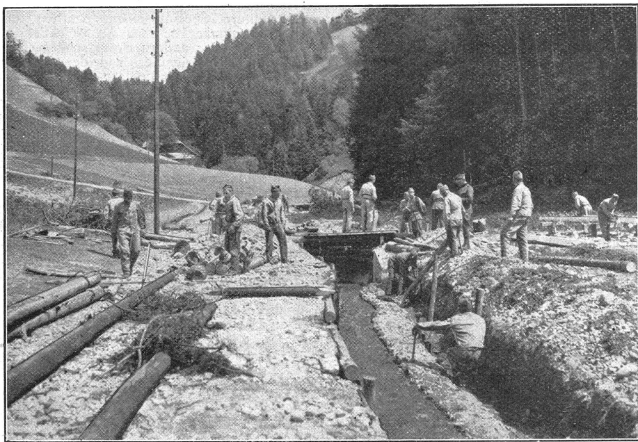
W. K. 1931 des Sap.-Bat. 3 im Unwettergebiet des Emmentals. Der weggerissene Steg wird ersetzt.
