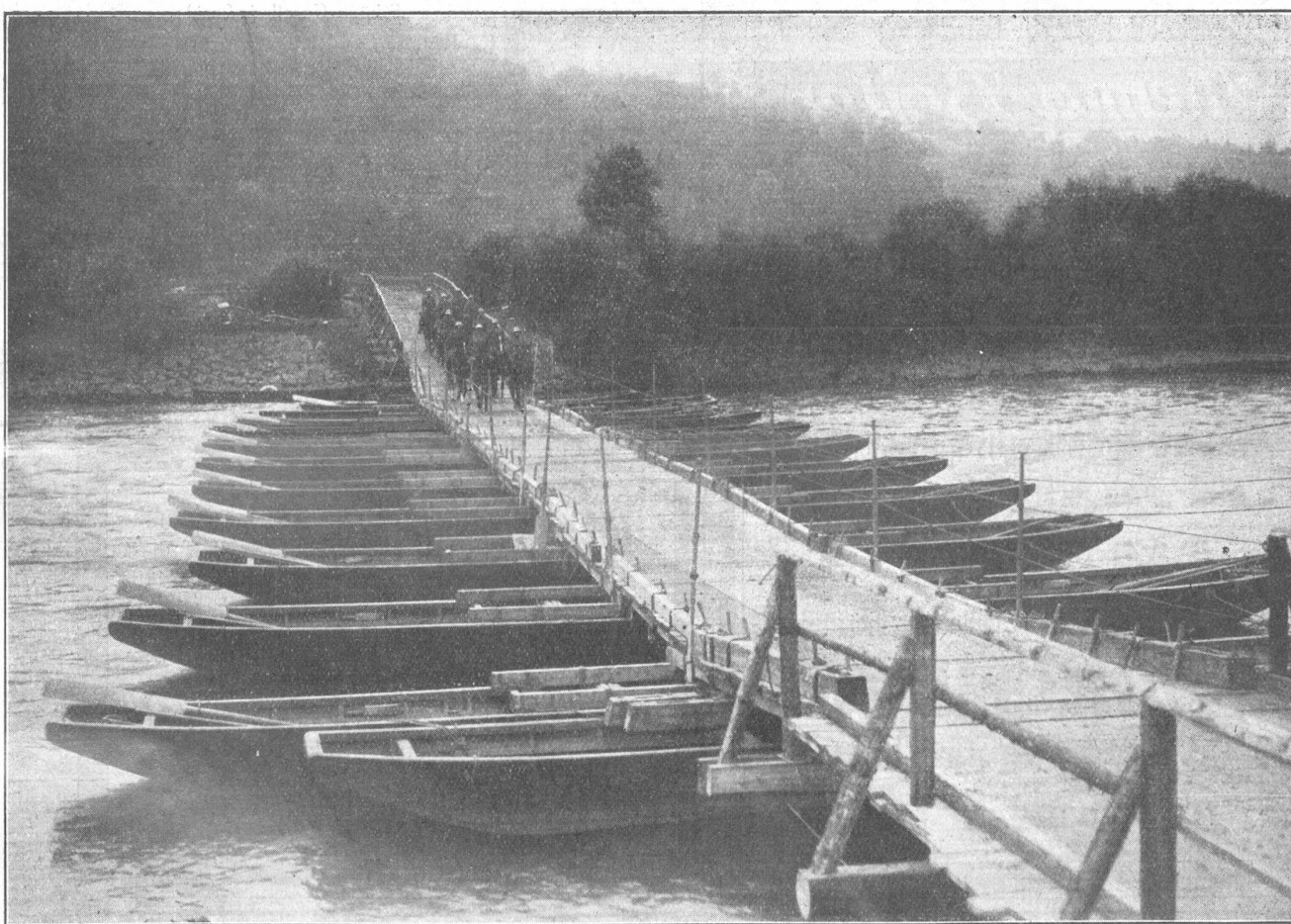
Schiffbrücke. — Pont flottant construit par nos pontonniers.
