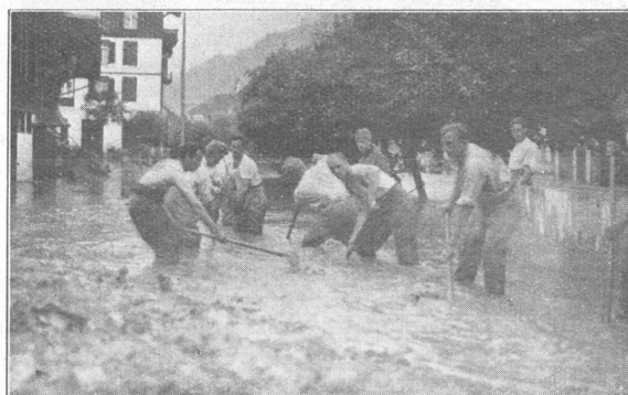
Lenk. — Absenken des Simmenbettes. La Lenk. — On reconduit la Simme dans son lit.
