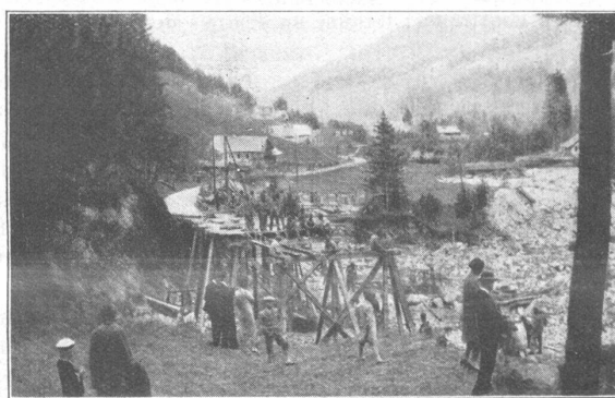
Die zerstörte Strasse ca. 1 km. unterhalb Adelboden. Die Bockbrücke im Bau.
