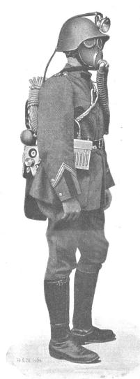
Bild links: Vollständige Ausrüstung eines Rettungsmannes der eidg. Rettungsstation Wimmis.
