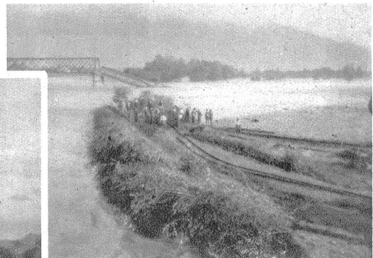
Bild oben: Dammbruch b. Schaan, Eisenbahnbrücke Buchs—Schaan, Vortreiben des provisorischen Dammes in Zusammenarbeit mit österreichischen Hilfstruppen.
