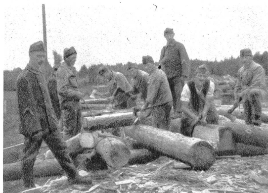
Oben: Abbundarbeiten für die Dienstbrücke über den Rhein unterhalb Bendern (Liechtenstein).
