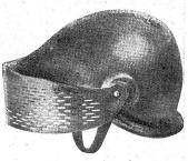
ist. Die Rarität des seinerzeit projektierten Helmes war aus 0,9 Millimeter dickem Stahlblech angefertigt. Was die Form anbelangte, so hatte es Kunstmaler l'Eplattenier verstanden, sie möglichst kriegstauglich und schmuck zu gestalten, bei verhältnismässig geringem Gewichte. Das abgelehnte Modell unterschied sich von andern, ausländischen dadurch, dass es keinerlei Un-
