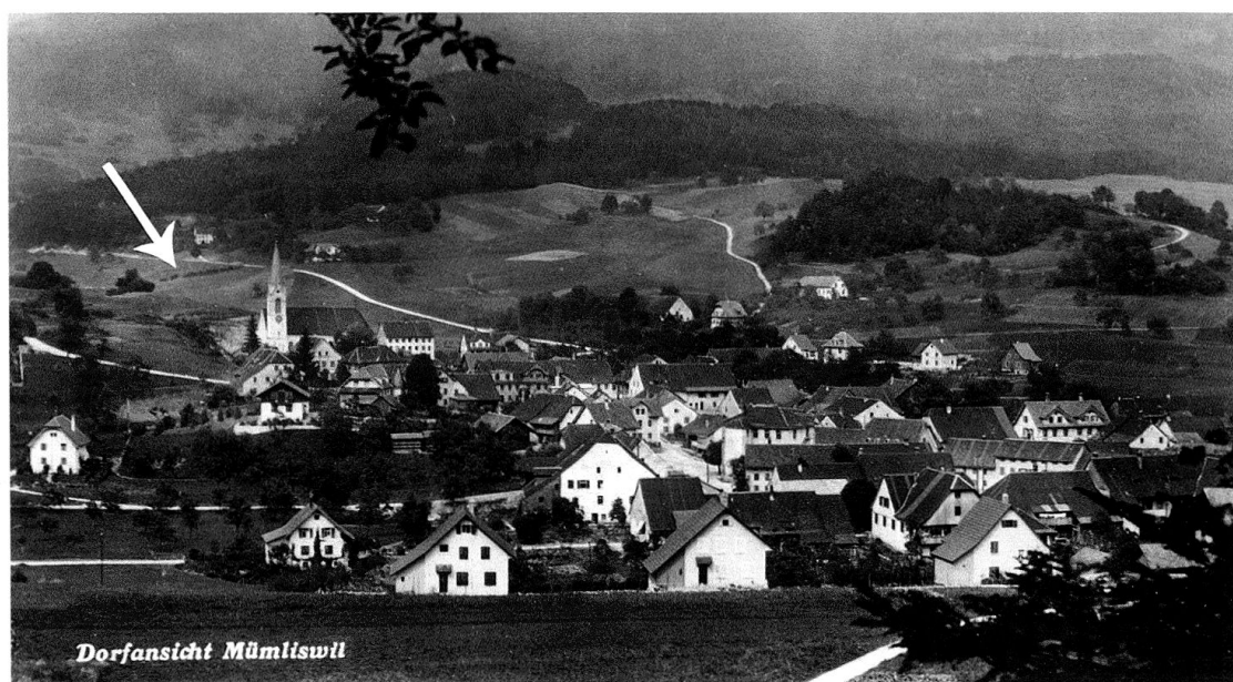
Abb. 1 Dorfansicht von Mümliswil aus den 1920er Jahren. Links und rechts des Kirchturms sind die beiden Höfe Vorderer Hübel und Hinterer Hübel zu sehen. Unterhalb der Strasse, rechts des Kirchturms, sind Weiden entlang eines Bächleins erkennbar. Entlang dieser Weiden etwa in der Mitte zwischen Strasse und Bäumen liegt die Fundstelle (Pfeil).
