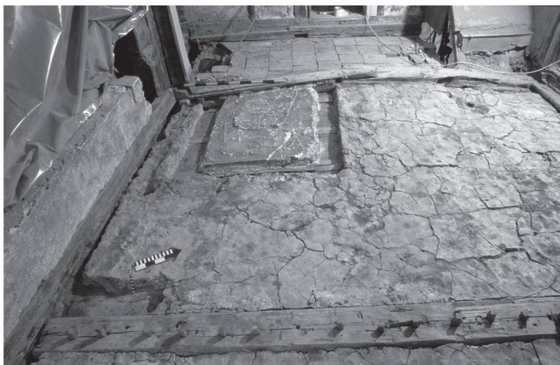
Abb. 15 Zug, St.-Oswalds-Gasse 10. Raum 10; Lehmörtelgestrich (1447d) mit ausgespartem Fundament des primären Ofens im Südwest-Bereich des Raumes.
